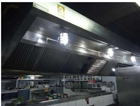
ภาพที่ 17 เครื่องดูดกลิ่นและควันในครัว
